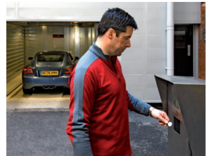
03 Der Fahrer bestätigt seinen Parkvorgang berührungslos mit seinem Transponder am Bedientableau. Laserscanner an der Decke prüfen die richtige Parkposition des Pkw, das Zufahrtstor wird geschlossen.
