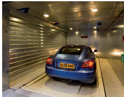
02 Nach dem Anwählen des Stellplatzes parkt der Fahrer den Pkw auf einer Parkpalette im hell erleuchteten Übergabebereich.
