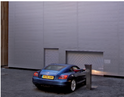
01 Im Innenhof befindet sich die Einfahrt zum Parksafesystem 583, der auf einer Grundfläche von nur ca. 10 m x 18 m und bei einer Gesamthöhe von 21 m 84 Stellplätze auf 10 Ebenen bietet.
