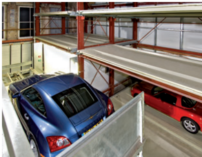
14 gleichzeitig bewegt sich das Shuttle horizontal. at the same time the shuttle moves horizontally.
