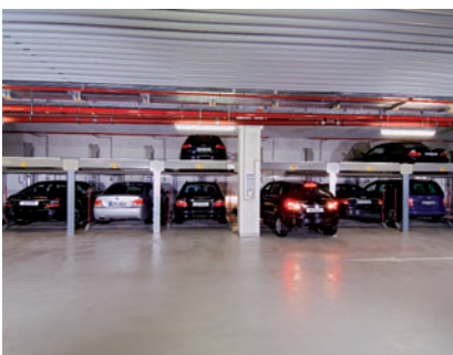
02 | D Der Pkw kann nun ausgefahren werden.
