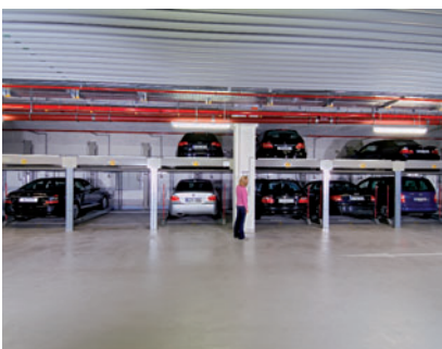
02 A Am Bedientableau wird OG-Stellplatz 112 ausgewählt.
