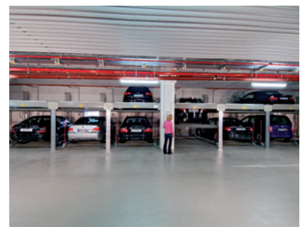
02 C Zum Absenken des OG-Stellplatzes 112 muss am Bedientableau der Startknopf gedrückt werden, bis der Stellplatz seine untere Endposition erreicht hat.
