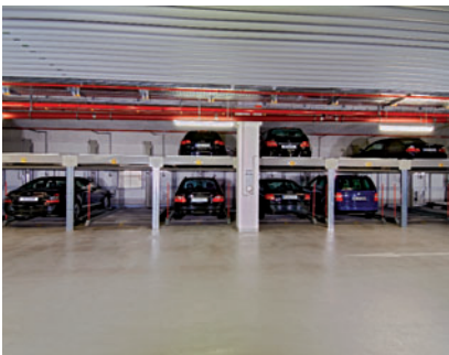
01 A Ausgangsstellung des 7er Moduls.
