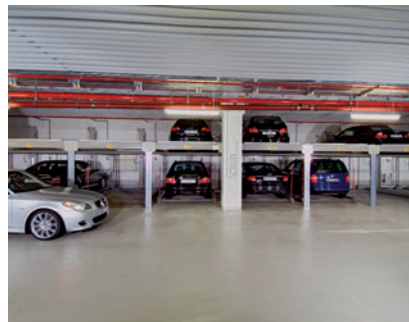
01 B Der Fahrer des silbernen BMW will seinen Stellplatz 115 belegen. Seine Zielposition unter Stellplatz 114 ist durch einen vorangegangenen Parkvorgang noch belegt.
